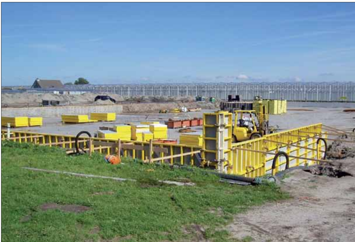
De bouw van de kelder in het Waalblok.
